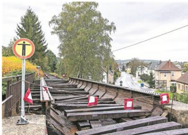
Die Windbergbahner haben auf der Brücke über die Coschützer Straße in Freital bereits mit dem Rückbau der Schwellen und Gleise begonnen, um den Brückenkörper instand setzen zu können. Noch fehlt aber ein Gutachten dafür. Foto: Karl-Ludwig Oberthür
